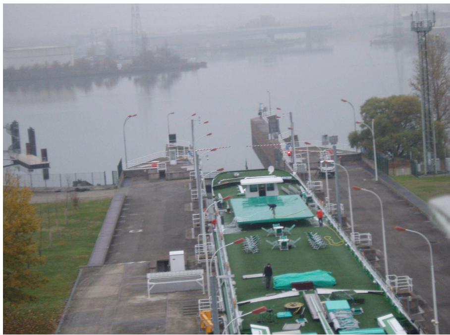
L'écluse du barrage de Pierre Bénite en pleine action .
