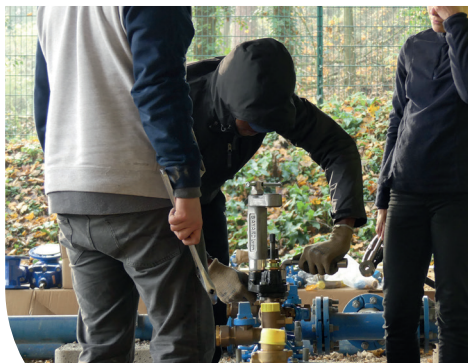
Travaux pratiques réalisés au hangar hydraulique d'Agrotec
