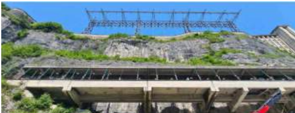
Visite du barrage de Génissiat
